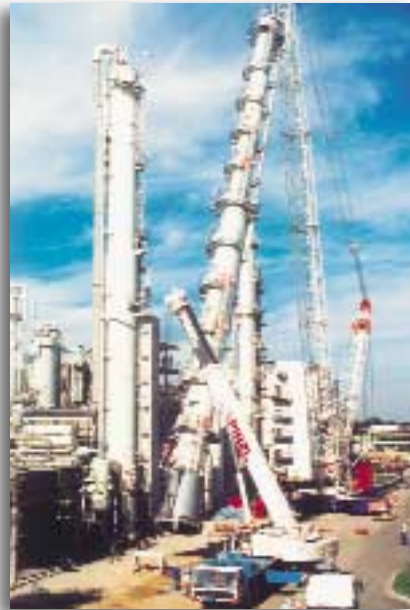
Aufstellen einer Destillationskolonne
