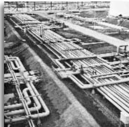
Produktleitungen bis DN 400 Shell-Raffinerie Ingolstadt
