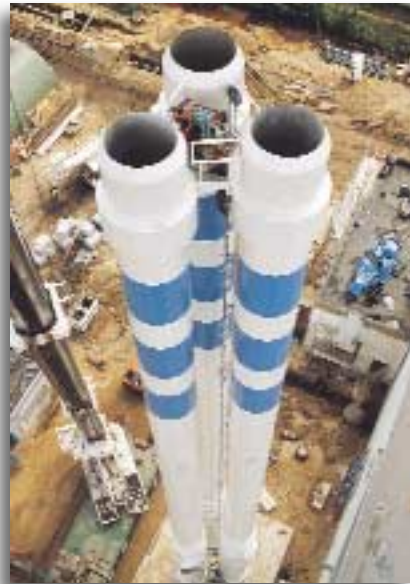
Schornsteinanlage Heizwerk Stendal
