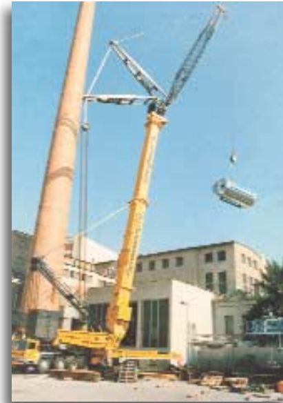
Einbringen des Dampfkessels Brauerei Löwenbräu
