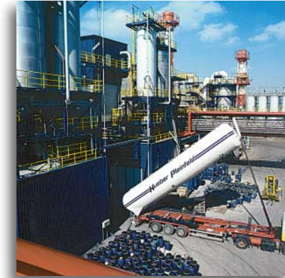
Sondermüllverbrennungsanlage der GSB Ebenhausen
