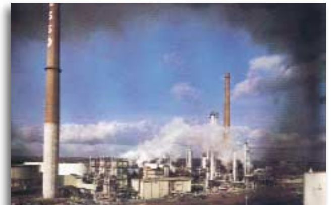
Kraftwerk Esso-Raffinerie Ingolstadt
