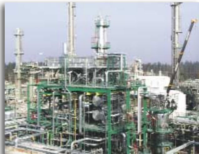
Aromatenanlage OMV-Raffinerie Burghausen
