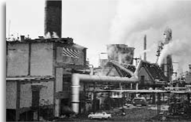
Kraftwerk Esso-Raffinerie Ingolstadt
