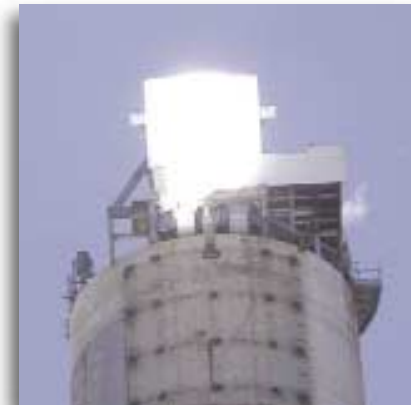
Solaranlage Receiver in Betrieb
