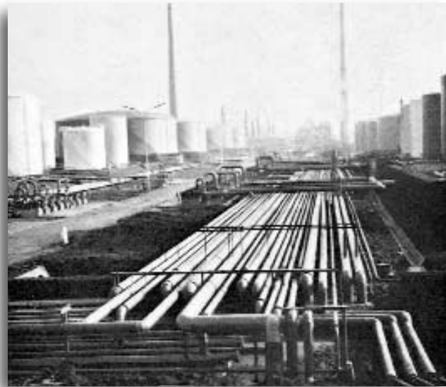
Produktleitungen bis DN 400 Shell-Raffinerie Ingolstadt
