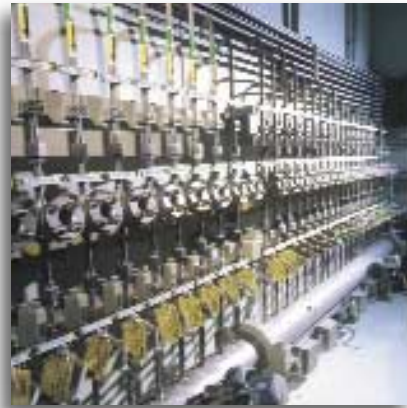
Lecküberwachungssystem im Forschungsreaktor FRM II Garching
