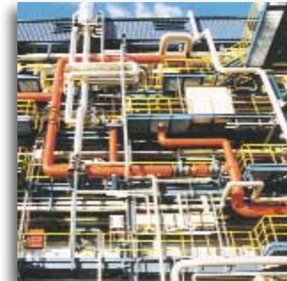
Verrohrung Sondermüllverbrennungsanlage Ebenhausen
