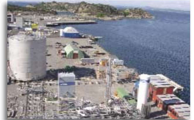
Erdgasverflüssigungs- anlage mit Schiffsverladung in Bergen, Norwegen
