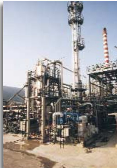
Umbau Raffinerie ERN Neustadt
