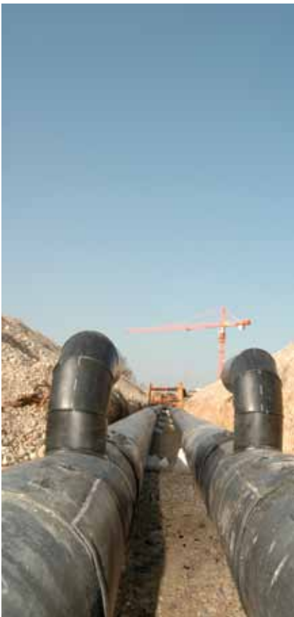
Verlegung von Fernwärmeleitungen in München.
