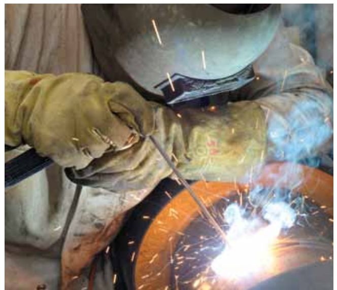
Schweißarbeiten an einer Fernwärmeleitung.
