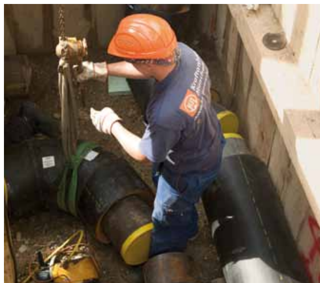
Verlegung von Fernwärmeleitungen in München.
