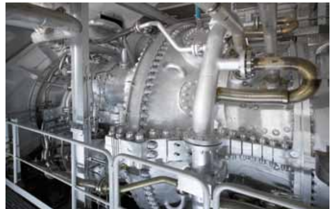
Bild oben: Gasturbine im Fernheizkraftwerk Linz-Mitte, GuD-Linie 1B.
